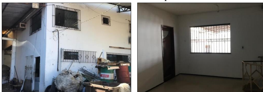
Foto 6 – Estrutura de Apoio
