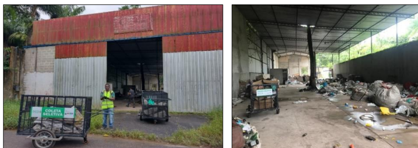
Foto 2 – Área destinada a construção da baia para recebimento do material
