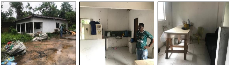
Foto 8 – Estrutura de Apoio
