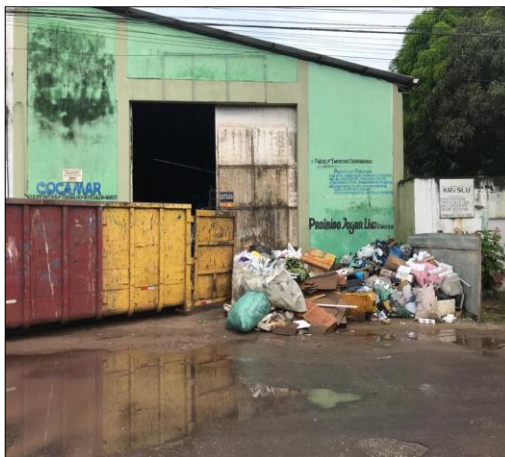
Foto 7 – Resíduos na frente do UT
